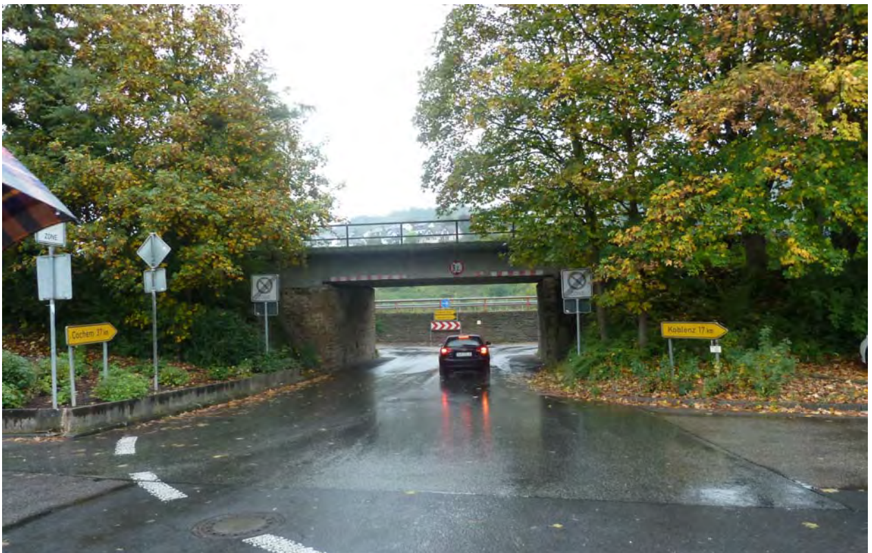
Bild 2: Stadtseitige Erdböschung mit Durchfahrt Schifferstraße - Bereich Bauwerkstyp 2b
