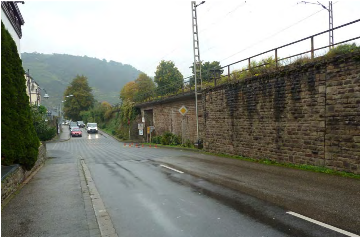
Bild 1: Stadtseitige Stützwände mit Durchfahrt Fährstraße - Bereich Bauwerkstyp 1
